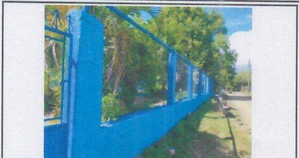
Foto 8: APLICACIÓN DE PINTURA EN MURO EXTERIOR.
