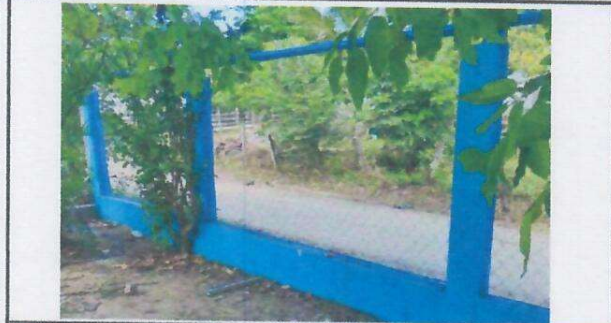
Foto 7: SUSTITUCIÓN DE MALLA EN MURO PERIMETRAL.
