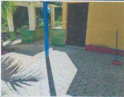
Foto 3: INSTALACION DE PISO CERAMICO.
