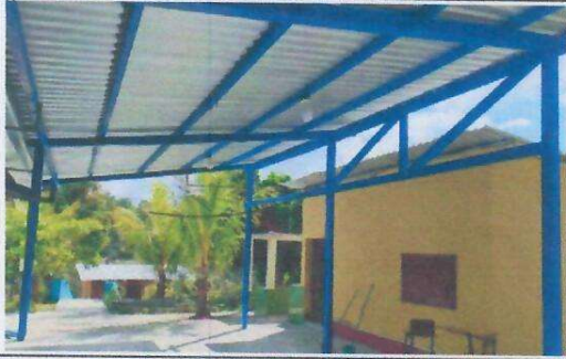
Foto 1: INSTALACION ESTRUCTURA METALICA COLUMNAS, BASE Y LAMINADO.
