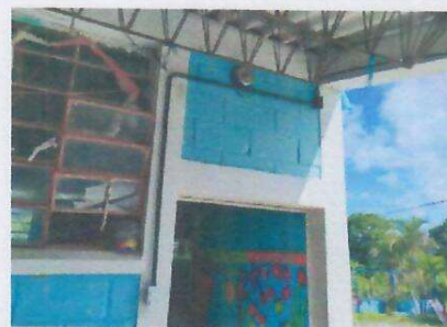
Foto 6: INSTALACION DE TUBERIA Y ACCESORIOS ELECTRICOS PARA INTERRUPTORES
