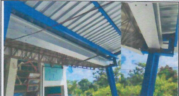
Foto 2: INSTALACION LAMINA TROQUELADA CAL.26. Y CANAL.
