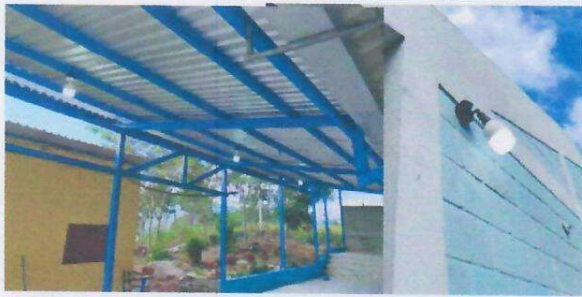
Foto 5: INSTALACION DE TUBERIA Y ACCESORIOS ELECTRICOS PARA ILUMINACION.
