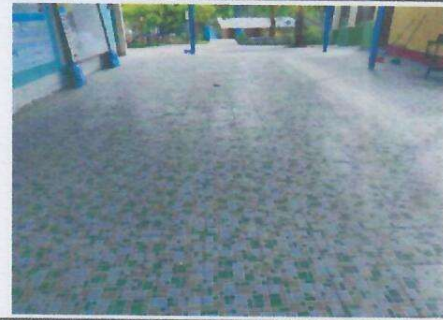
Foto 4: INSTALACION DE PISO CERAMICO.
