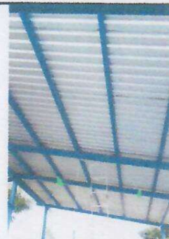
Foto 6: INTALACION DE CABLEADO PARA INSTALACION ELECTRICA.
