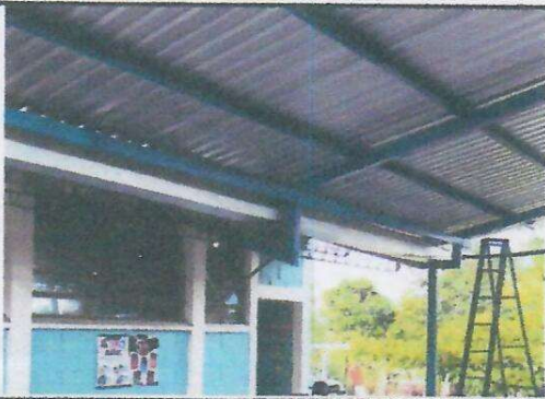
Foto 3: INSTALACION DE CANAL DE METAL EN TECHO DE AULAS.
