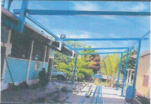
Foto 1: INSTALACION ESTRUCTURA METALICA BASE PARA LAMINA.
