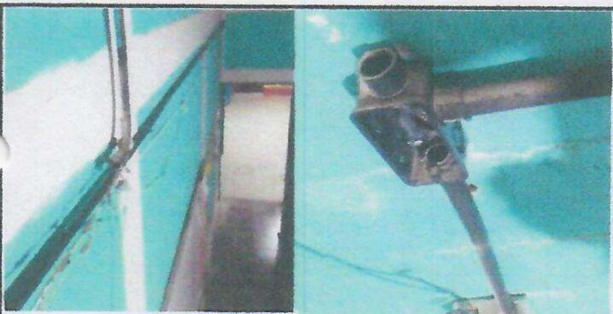
Foto 5: INSTALACION DE TUBERIA Y ACCESORIOS ELECTRICOS PARA ILUMINACION E INTERRUPTOR.
