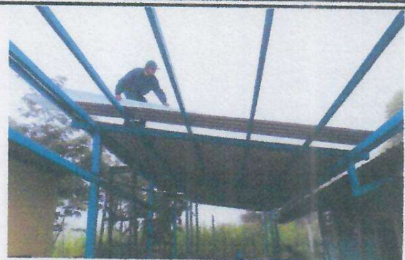
Foto 2: INSTALACION LAMINA TROQUELADA CAL.26.
