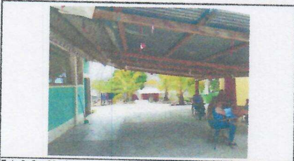
Foto 3: Cambio de techo de madera por estructura metalica
