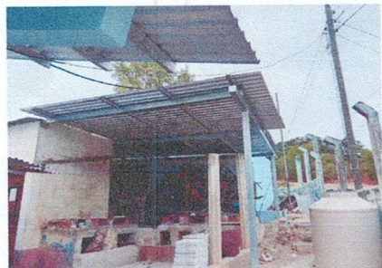
Foto 1: Techo de Cocina
