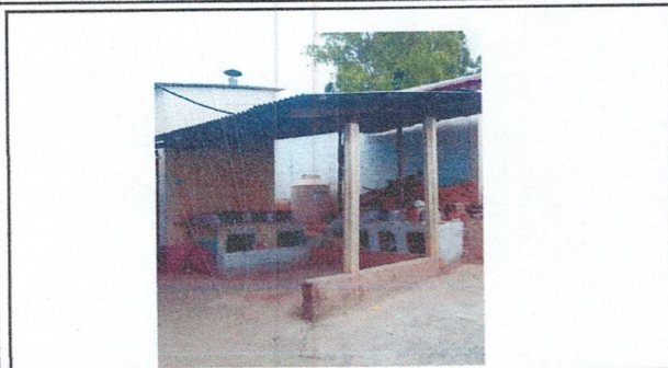
Foto 1: Techo de Cocina
