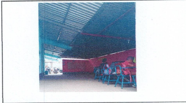
Foto2: techo de galera frente a aulas
