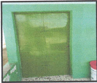
Foto 1: Mantenimiento a estructura (lijado, cambio de tubo, cepillado, sujeciones, aplicación de pintura) en aula
