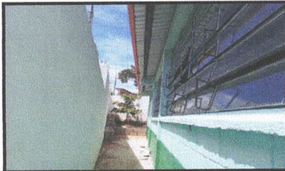
Foto 5: Fabricación e instalación de balcones de hierro en ventana
