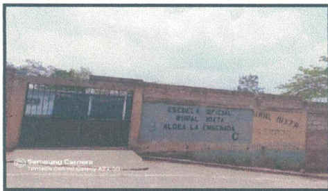
Foto 5: Pintura en muros exteriores e interiores
