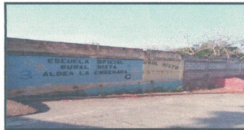
Foto 4: Reparación de muro perimetral de block.
