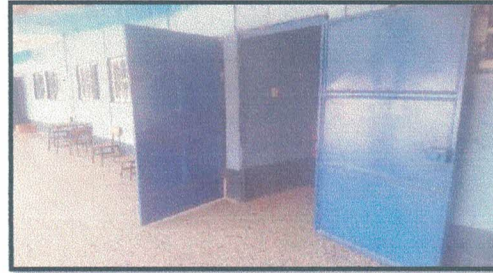
Foto 8: Sustitución de chapa de puertas en aulas
