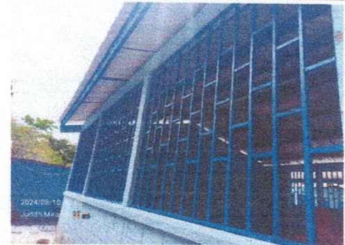
Foto 6: Sustitución de Balcones.
