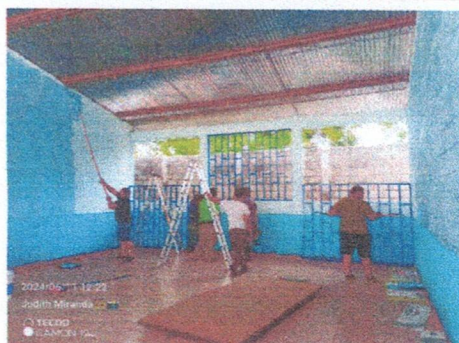
Foto 6: Sustitución de Balcones.
