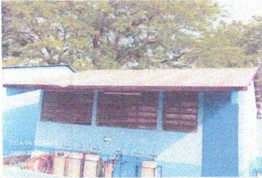
Foto 1: Lámina Acanalada a sustituir por lamina troquelada aluzinc calibre 26 legitima. Y Cambio de Ventanas por Balcones.
