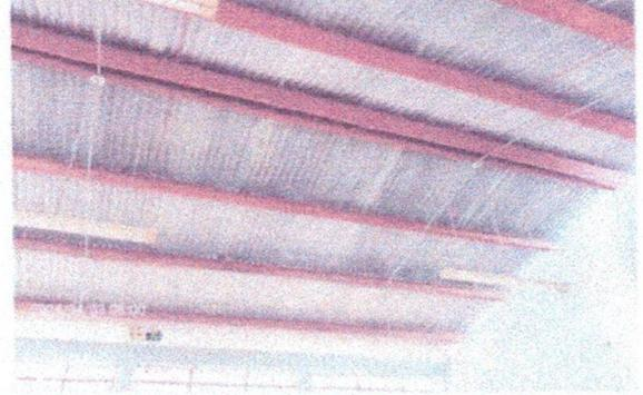
Foto 2: Lámina Acanalada a sustituir por lamina troquelada aluzinc calibre 26 legitima. Y Cambio de Ventanas por Balcones.
