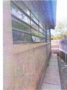
Foto 6: Reparación de Ventanas, remocion de balcones y sustitución de balcones metalicos para aula.
