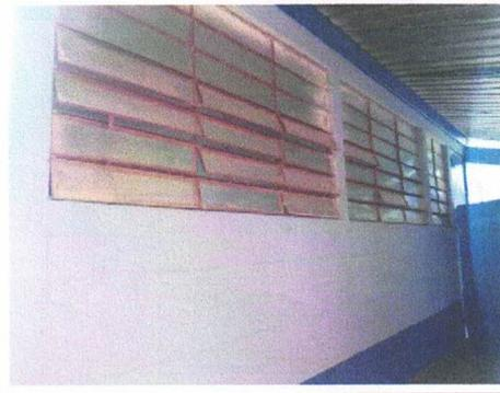
Foto 4: Reparación de Ventanas, remocion de balcones y sustitución de balcones metalicos para aula.
