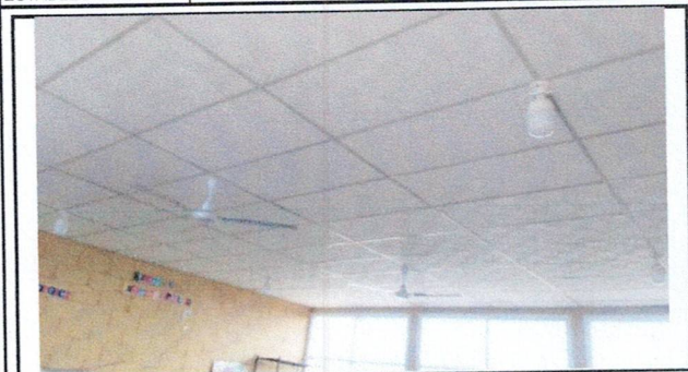
Foto 1: Instalación de cielo falso reticulado.
