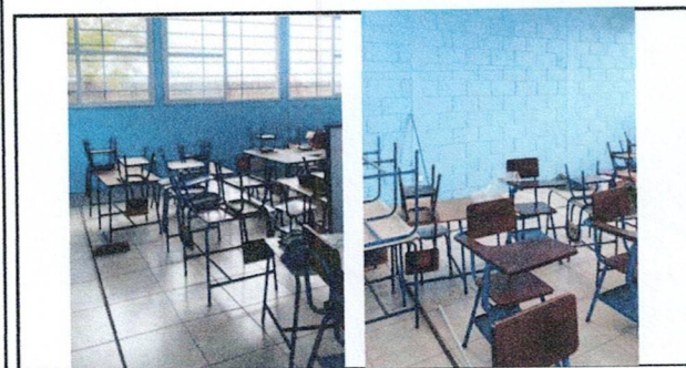
Foto 5: Instalación de piso cerámico en aula.
