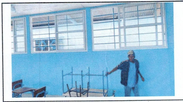
Foto 4: Instalación de ventanería de PVC y Pintura en paredes.
