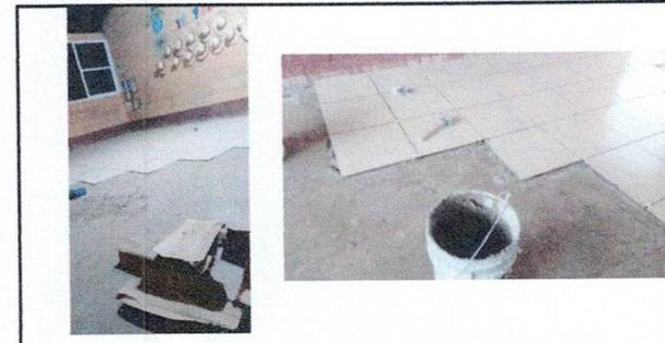
Foto 6: Instalación de piso cerámico.
