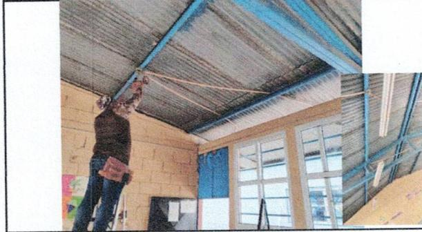
Foto 2: Desmontaje de sistema eléctrico existente deteriorado.
