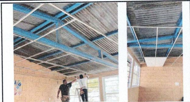
Foto 1: Instalación de cielo falso reticulado.
