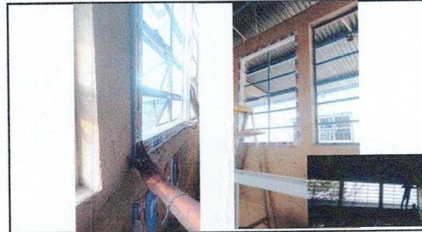
Foto 4: Instalación de ventanería de PVC.
