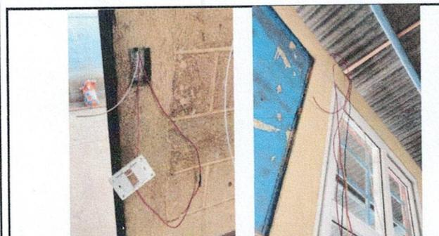
Foto 3: Instalación de unidades de luz y fuerza. Interruptores, iluminación y tomacorrientes.
