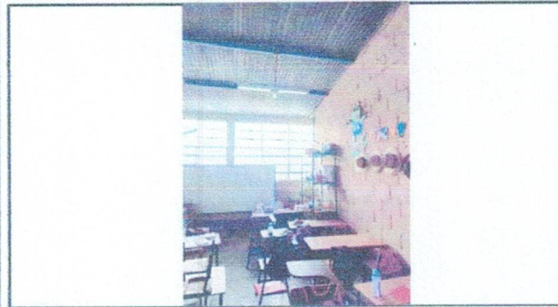
Foto 1: Colocacion de cielo falso en aulas.
