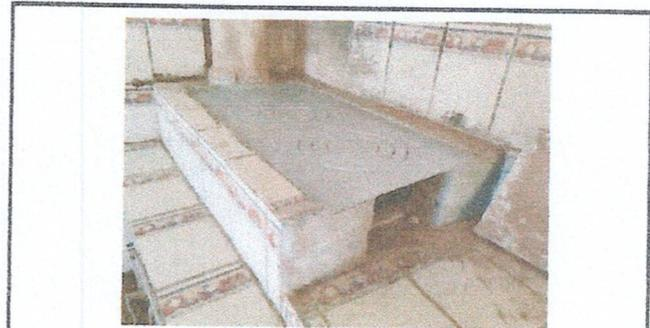
Foto 10: Sustitución de plancha d de metal de 3 hornillas y ampliación de Estufa Rural.
