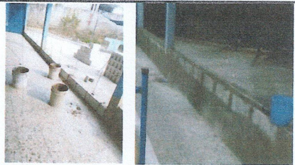
Foto 4: Sustitucion de muro tipo pretil.
