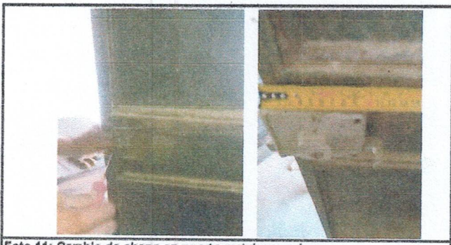
Foto 11: Cambio de chapa en puerta metal en cocina.
