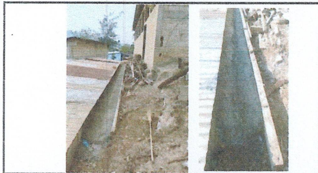
Foto 7: Fundición de cuneta de concreto para protección de muro de contención.
