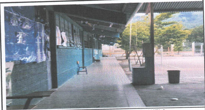
REPARACION CANAL PLUVIAL DE PVC TODA LA ESCUELA
