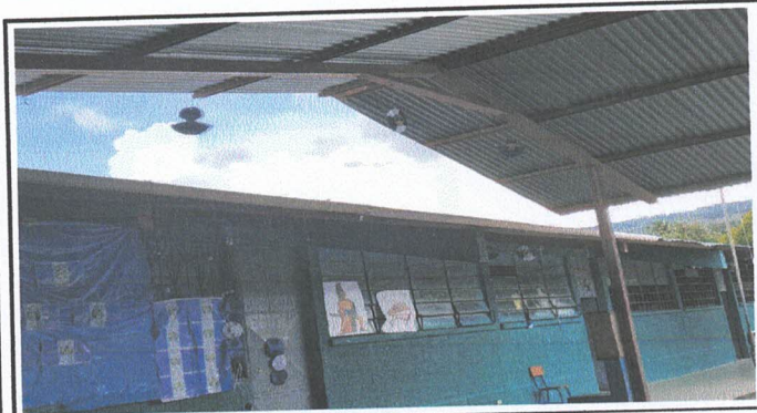
REPARACION DE CANAL PLUVIAL DE PVC
