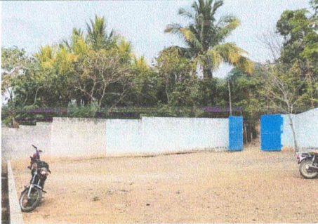
Foto 3: Muro sobre el que se colocara malla metálica.
