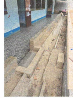
Foto 4: Punto donde se colocara unas gradas extras.
