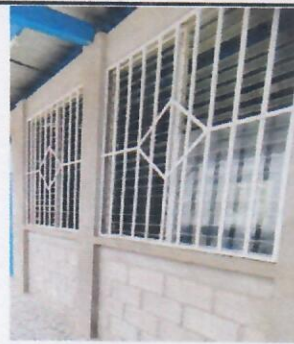
Foto 2: INSTALACION DE BALCONES METALICOS
