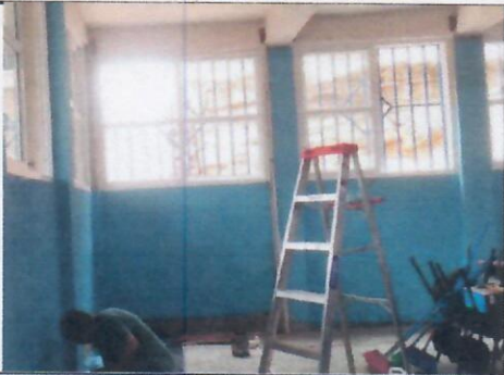
Foto 3: APLICACIÓN DE PINTURA
