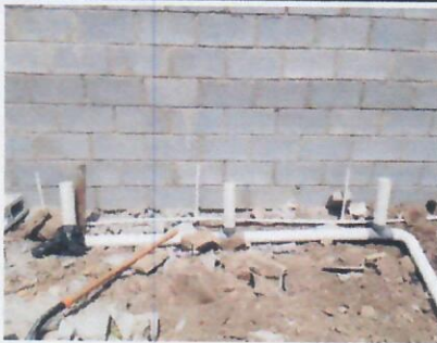
Foto 5: INSTALACION DE TUBERIA DE DRENAJE Y AGUA POTABLE
