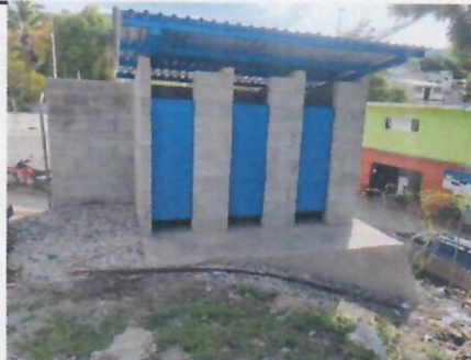
Foto 6: MURO TABIQUE, TORTA DE CEMENTO, LAMINA Y ESTRUCTURA METALICA EN SERVICIOS SANITARIOS
