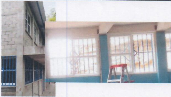
Foto 1: INSTALACION DE VENTANAS DE PVC
