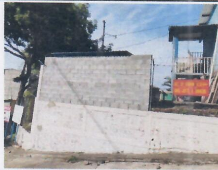
Foto 4: SUSTITUCION DE MURO PERIMETRAL DE MALLA POR TIPO BLOCK
