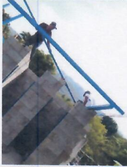
Foto 7: ESTRUCTURA METALICA Y LAMINA EN SERVICIOS SANITARIOS
