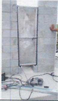
Foto 9: COLOCACION DE PUERTAS EN SERVICIOS SANITARIOS
