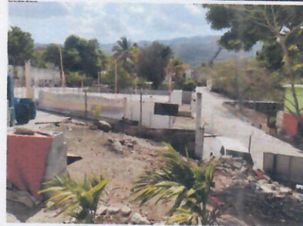
Foto 4: Sustituir la malla metalica por block reforzado, en muro perimetral.
