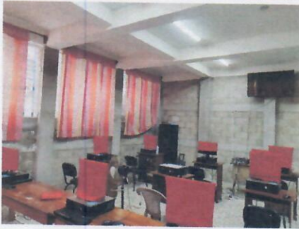
Foto 1: Colocacion de Pintura en paredes de aulas.
