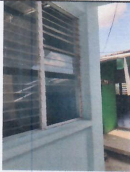
Foto 3: Colocacion de balcones metalicos.
