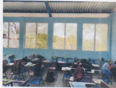
Foto 2: Sustitucion de ventaneria de aluminio tipo paletas por ventanas de PVC.
