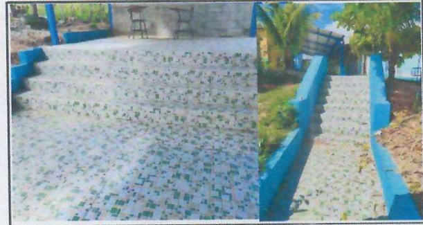
Foto 4: INSTALACION DE PISO CERAMICO.
