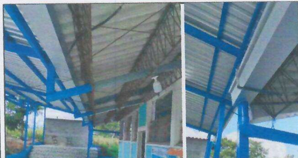
Foto 3: INSTALACION DE CANAL DE METAL EN TECHO DE AULAS.
