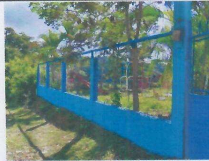
Foto 10: SUSTITUCION DE MALLA EN MURO PERIMETRAL.
