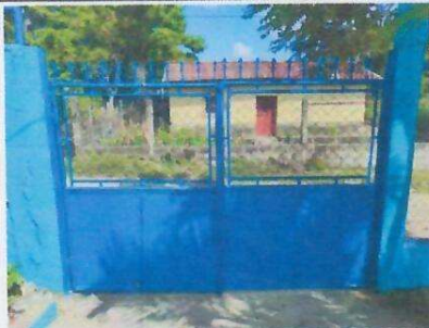
Foto 11: REPARACION DE PORTON METALICA Y MANTENIMIENTO.
