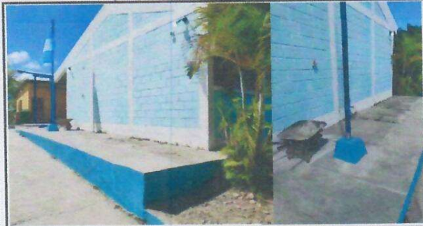
Foto 7: SUSTITUCION O INSTALACION DE PISO DE TORTA DE CONCRETO.
