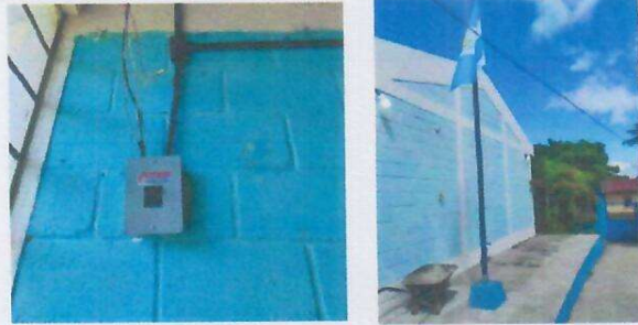
Foto 12: SUSTITUCION DE TABLERO ELECTRICO PRINCIPAL Y REUBICACION DE ASTA PARA BANDERA.
