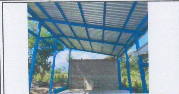
Foto 1: INSTALACION ESTRUCTURA METALICA BASE PARA LAMINA.
