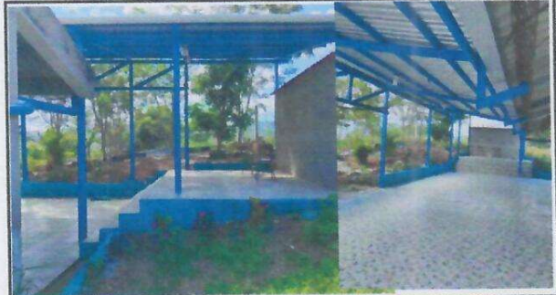
Foto 2: INSTALACION LAMINA TROQUELADA CAL.26.
