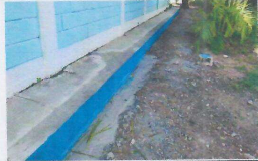
Foto 8: REPARACION DE BANQUETA PERIMETRAL DE AULAS.
