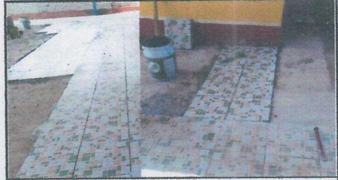
Foto 4: INSTALACION DE PISO CERAMICO.
