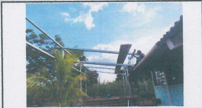
Foto 1: INSTALACION ESTRUCTURA METALICA BASE PARA LAMINA.
