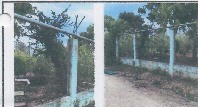
Foto 9: SUSTITUCION DE MALLA EN MURO PERIMETRAL.
