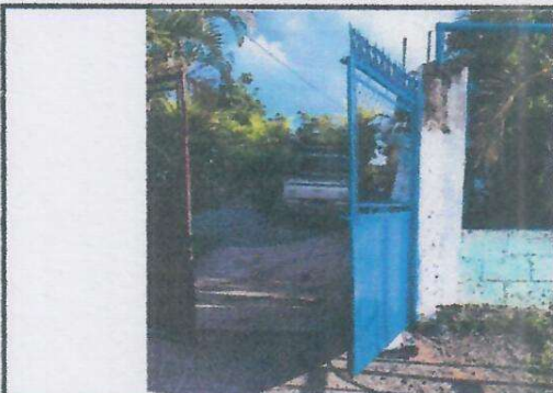
Foto 10: REPARACION DE PORTON METALICA Y MANTENIMIENTO.
