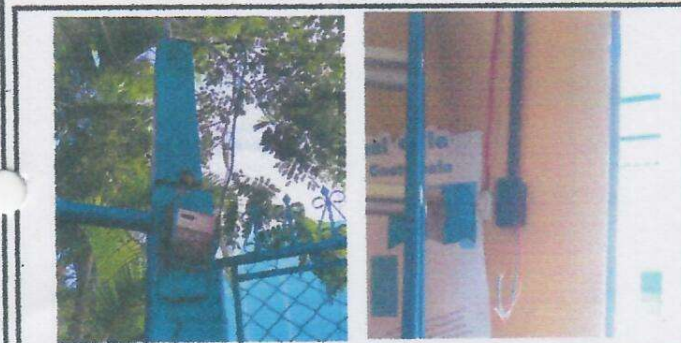
Foto 5: INSTALACION DE TUBERIA Y ACCESORIOS ELECTRICOS PARA ILUMINACION E INTERRUPTOR, COMO EL CAMBIO DEL CABLEDO DE ACOMETIDA ELECTRICA.
