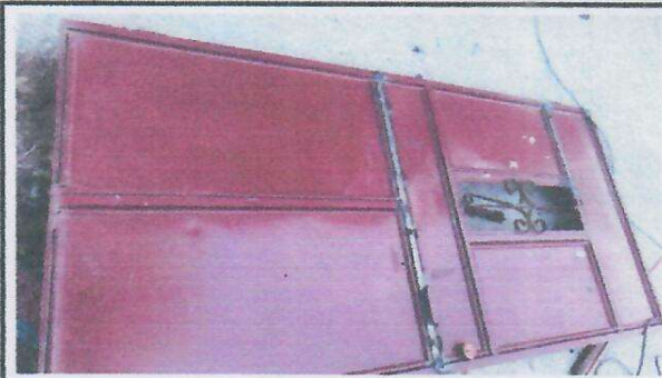
Foto 8: REPARACION DE PUERTA METALICA Y MANTENIMIENTO.
