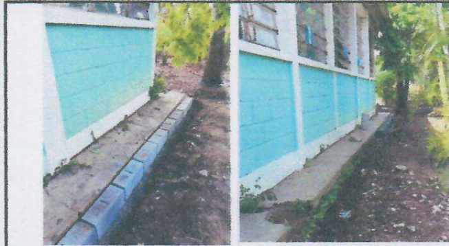
Foto 7: REPARACION DE BANQUETA PERIMETRAL DE AULAS.
