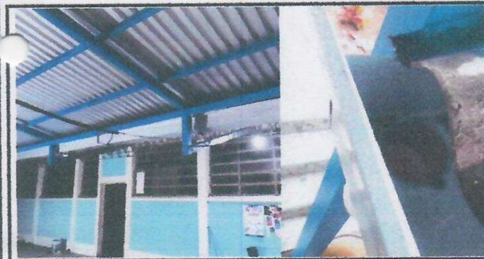
Foto 3: INSTALACION DE CANAL DE METAL EN TECHO DE AULAS.
