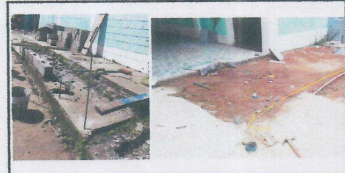
Foto 6: SUSTITUCION O INSTALACION DE PISO DE TORTA DE CONCRETO.
