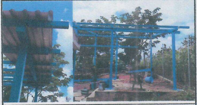
Foto 2: INSTALACION LAMINA TROQUELADA CAL.26.
