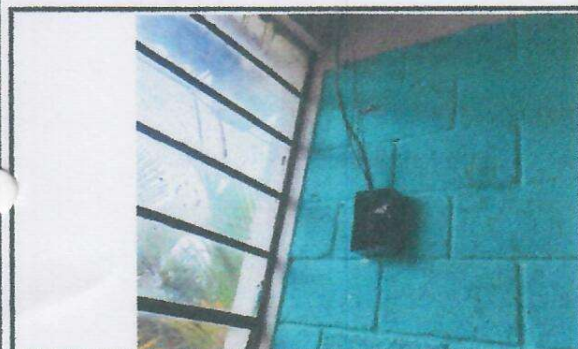
Foto 11: SUSTITUCION DE TABLERO ELECTRICO PRINCIPAL.
