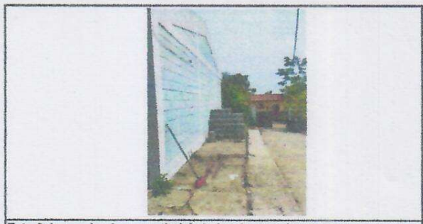
Foto 6: Lugar donde se sustituirá el piso de torta de concreto.
