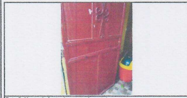
Foto 5: Mantenimiento de puerta de metal.
