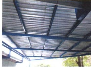
Foto 2: Sustitución o instalación de estructura de metal con columnas
