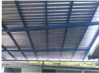
Foto1: .Sustitución o instalación de lamina por lamina calibre 26 en la galera
