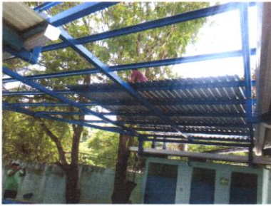
Foto1: .Sustitucion o instalacion de lamina por lamina calibre 26 en la galera
