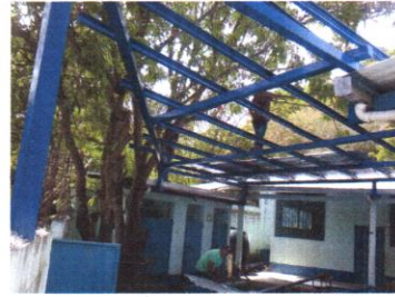
Foto 2: Sustitución o instalacion de estructura de metal con columnas
