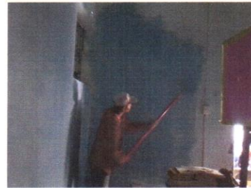
Foto 4: Pintura en muros exteriores e interiores.
