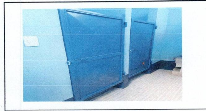
Foto 6: Remozamiento de puertas en baños, lijado, pintura y refrozamiento de marco
