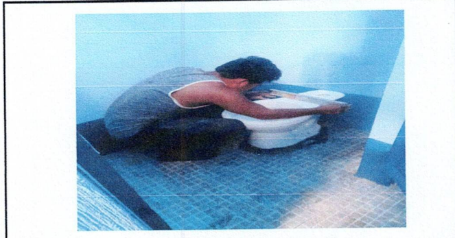
Foto7: Cambio de Inodoros
