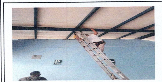
Foto 5: Instalación de Luminarias( Alambre, Bombillas y cable)
