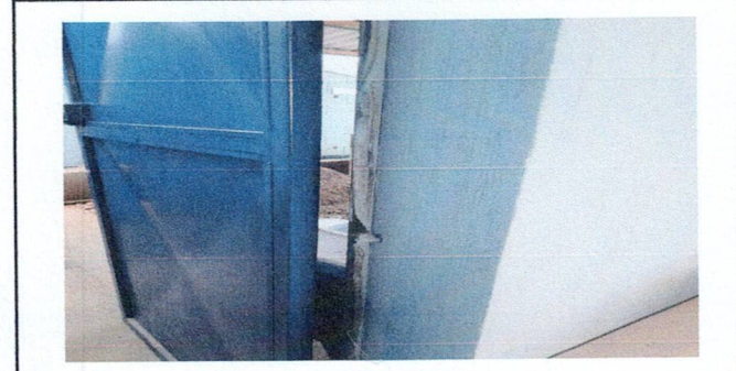
Foto 4: Mantenimiento de Puertas, lijado, pintura y reforzamiento de marco.
