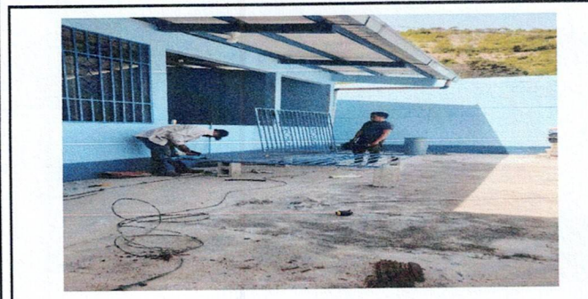
Foto 3: Mantenimiento de sedazo en balcones
