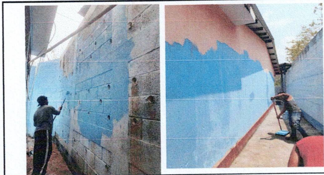
Foto1: Pintura en muros, en interiores y exteriores
