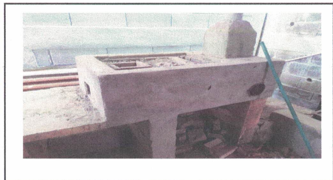
Foto 9: Construcción de Estufa Rural Completa
