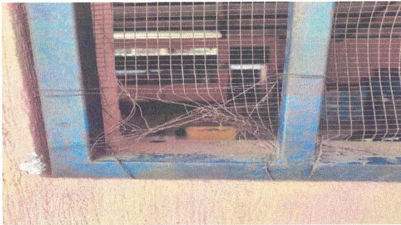
Foto 3: Mantenimiento de sedazo en balcones
