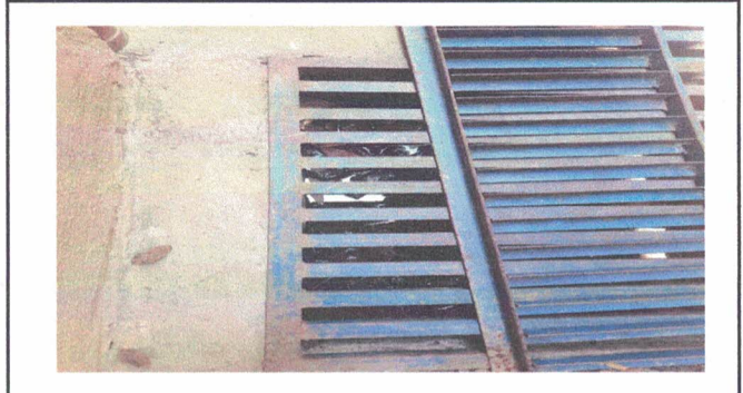
Foto 8: Instalación de Drenaje Pluvial
