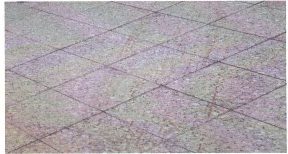
Foto 2: Mantenimiento de piso de granito
