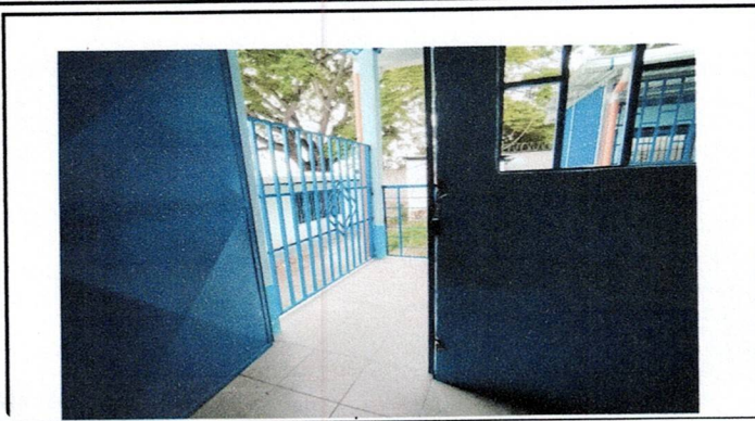
Foto 1: Instalación de Puerta
