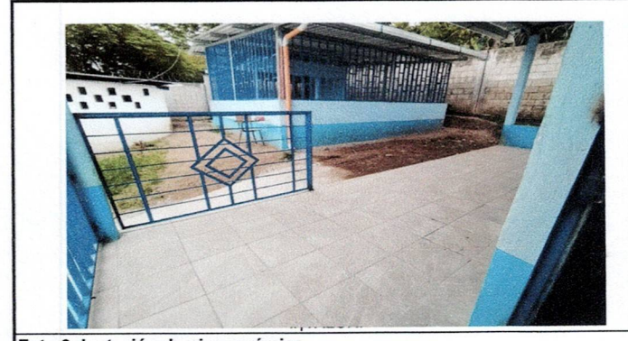
Foto 6: Instalación de piso cerámico
