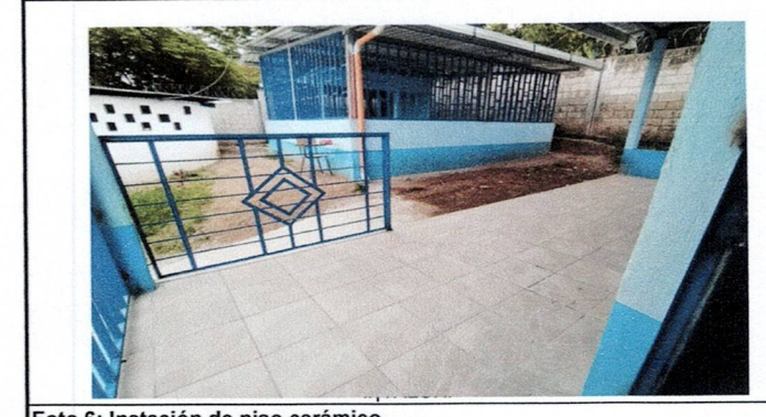
Foto 6: Instalación de piso cerámico
