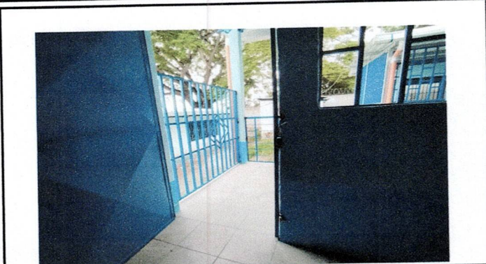
Foto 1: Instalación de Puerta
