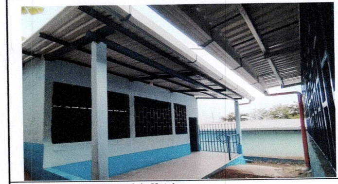
Foto 4: Instalación de canal de Metal
