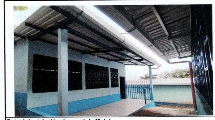
Foto 4: Instalación de canal de Metal
