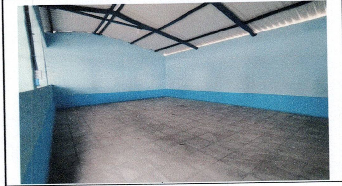
Foto 2: Pintura en muros de interiores
