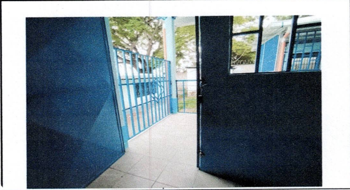
Foto 1: Instalación de Puerta
