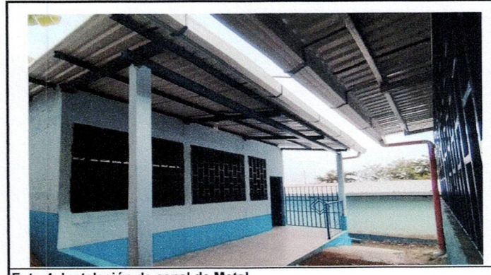
Foto 4: Instalación de canal de Metal
