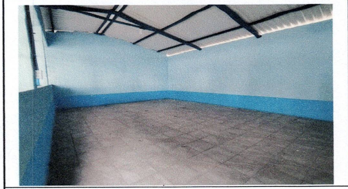
Foto 2: Pintura en muros de interiores
