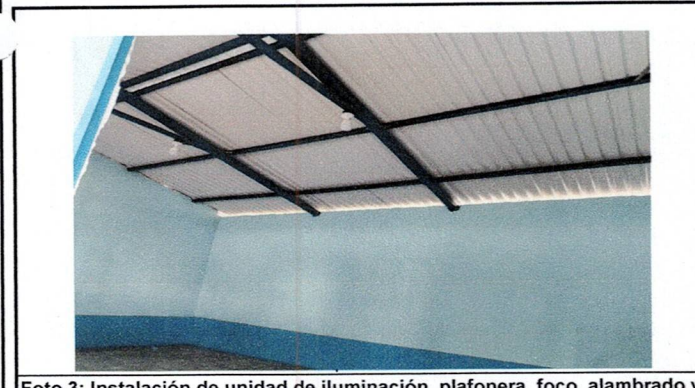
Foto 3: Instalación de unidad de iluminación, plafonera, foco, alambrado y ducto.
