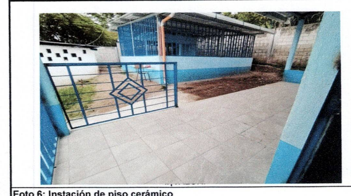
Foto 6: Instación de piso cerámico
