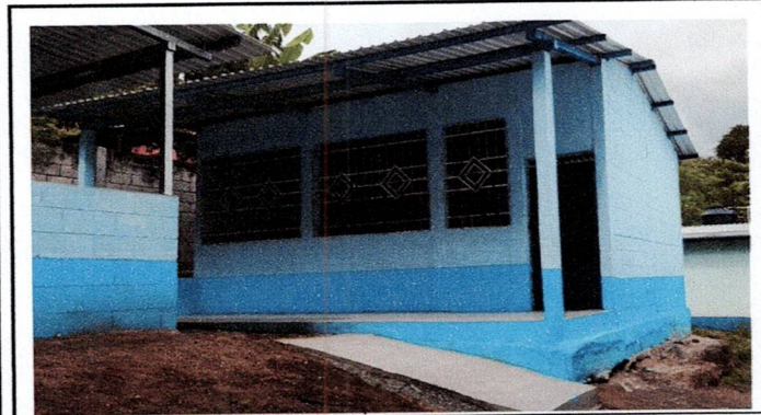
Foto 3: Reparación de gradas para acceder al aula
