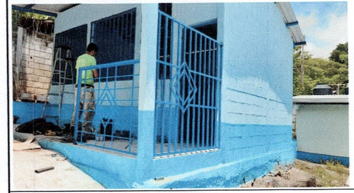
Foto 4 : Sustitución de balcones de metal
