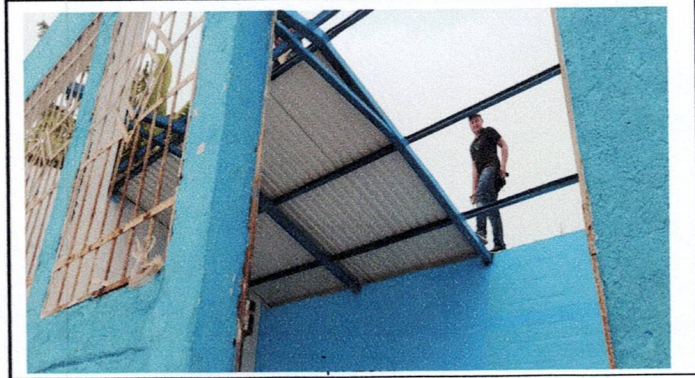
Foto 2: Instalación de lámina troquelada aluzinc
