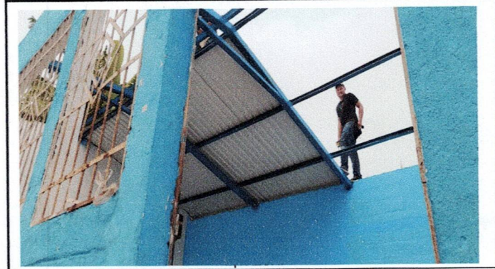
Foto 2: Instalación de lámina troquelada aluzinc
