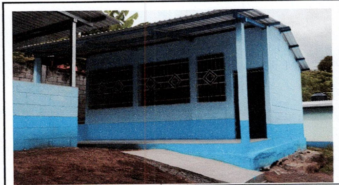
Foto 3: Reparación de gradas para acceder al aula
