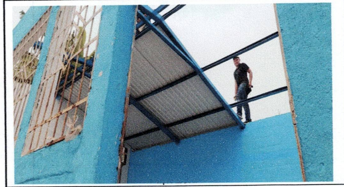
Foto 2: Instalación de lámina troquelada aluzinc
