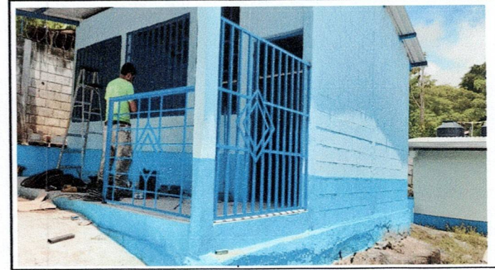
Foto 4 : Sustitución de balcones de metal
