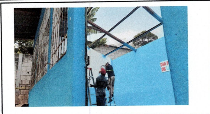
Foto 1: Mantenimiento a estructura de soporte de metal
