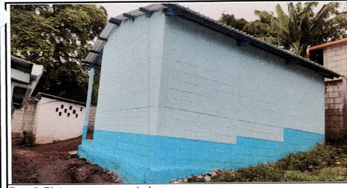
Foto 5: Pintura en muros exteriores
