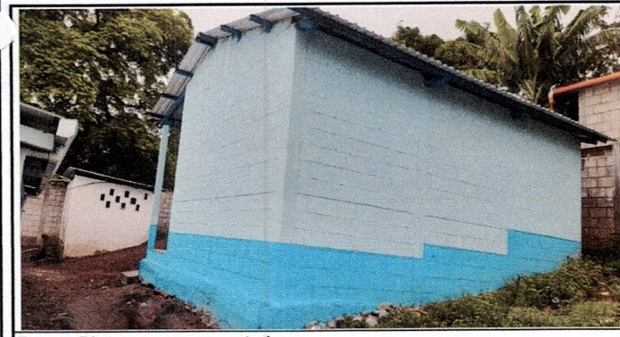
Foto 5: Pintura en muros exteriores
