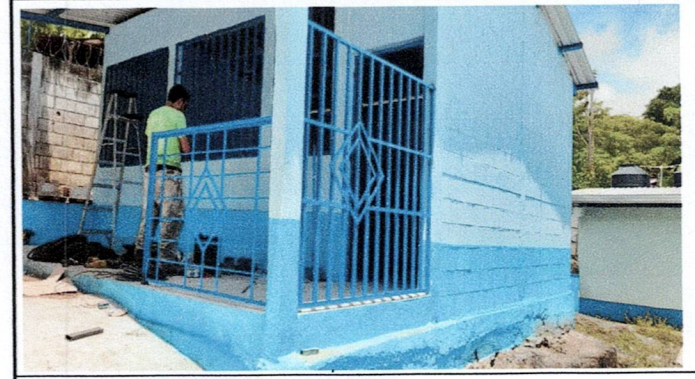
Foto 4 : Sustitución de balcones de metal
