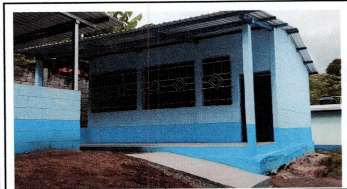
Foto 3: Reparación de gradas para acceder al aula
