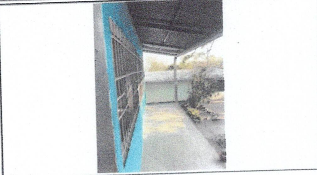
Foto 1: Reparación de Aula Pura.
