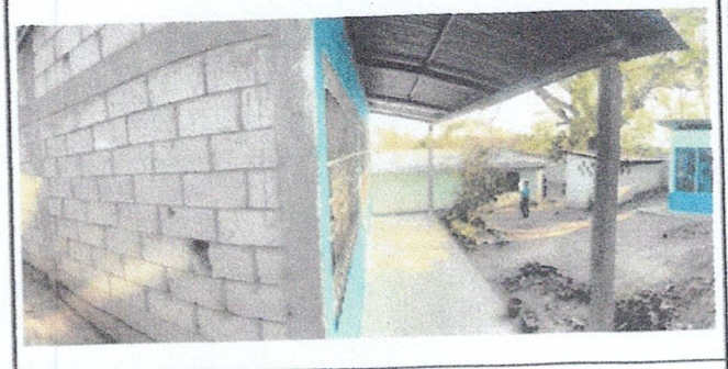
Foto 2: Reparación de Aula Pura.
