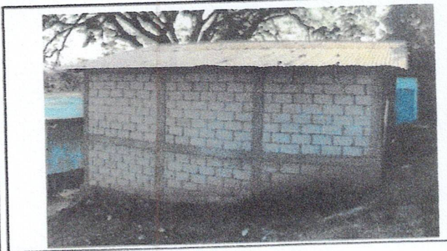
Foto 3: Reparación de Aula Pura.
