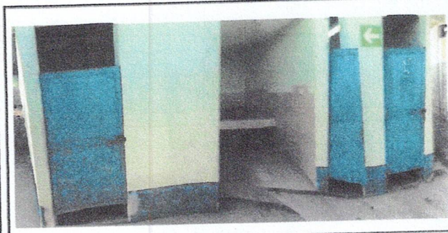
Foto 5: Reparación de Servicios Sanitarios-
