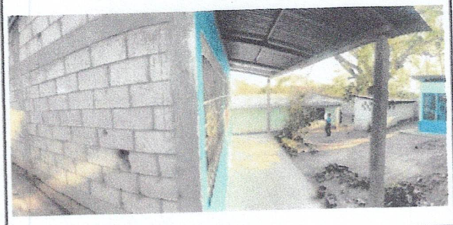
Foto 2: Reparación de Aula Pura.
