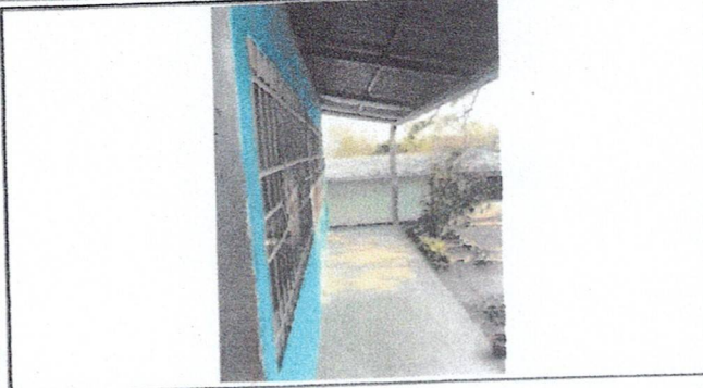
Foto 1: Reparación de Aula Pura.
