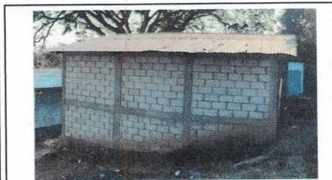
Foto 3: Reparación de Aula Pura.
