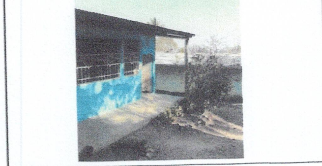
Foto 4: Reparación de Aula Pura.
