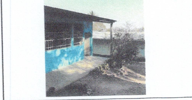
Foto 4: Reparación de Aula Pura.
