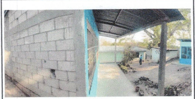
Foto 2: Reparación de Aula Pura.
