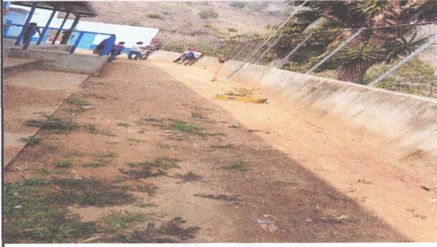
Foto 6: Instalación de plancha de concreto en patio.
