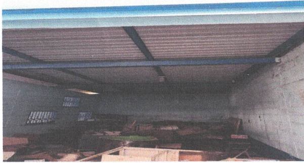
Foto1: Pintura, marquesina e instalación de lámina transparente.
