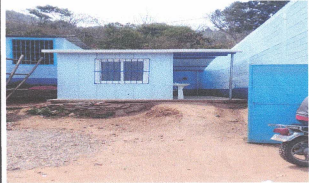
Foto 4: Sustitución de banqueta en cocina.
