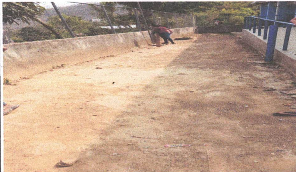
Foto 5: Instalación de columna tensora en muros.
