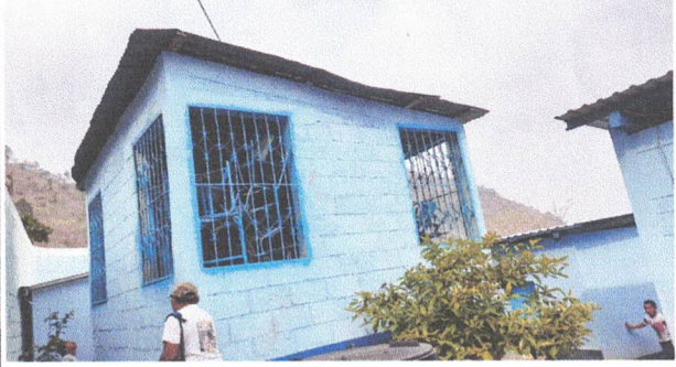
Foto 2: Sustitución de lámina y estructura de soporte en bodega.
