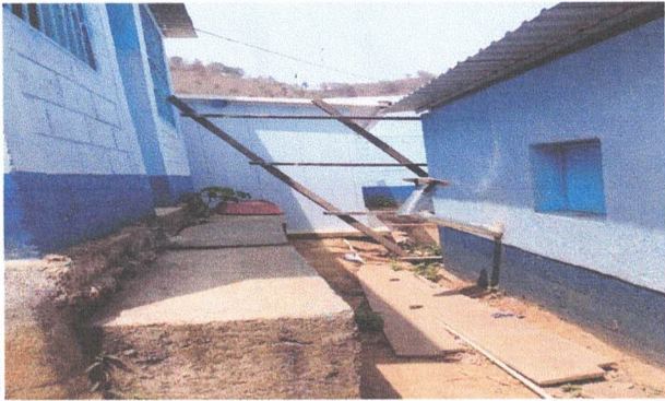
Foto 3: Sustitución de banqueta en bodega.
