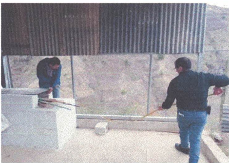
Foto 5: estufa que será sustituida.
