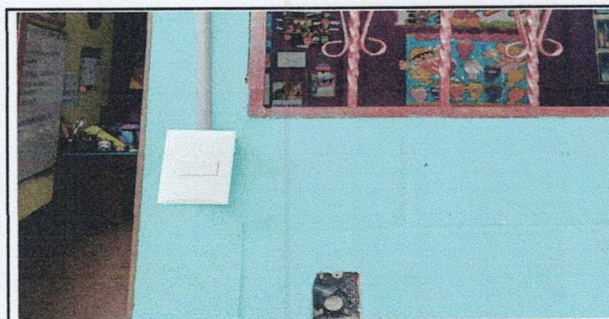
Foto 5: SUSTITUCIÓN DE INTERRUPTORES SIMPLES (CAJA, APAGADOR, ALAMBRADO Y DUCTO)
