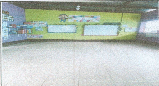
Foto 1: INSTALACION DE PISO CERÁMICO EN AULAS
