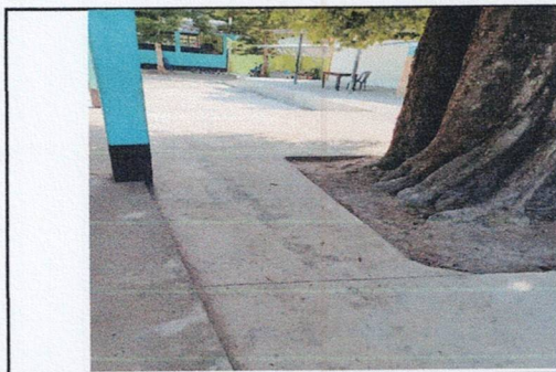
Foto 9: SUSTITUCION DE PLANCHAS DE CONCRETO DE PATIO
