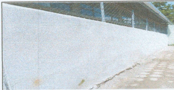
Foto 6: REPELLO MURO PERIMETRAL
