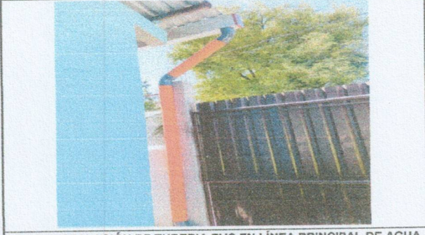
Foto 8: INSTALACIÓN DE TUBERIA PVC EN LÍNEA PRINCIPAL DE AGUA PLUVIAL
