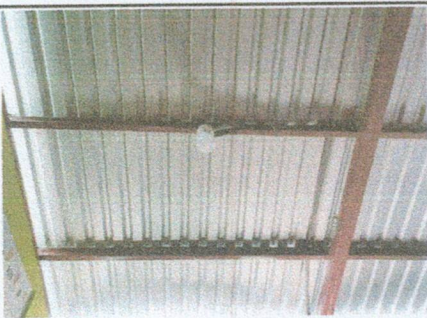
Foto 3: SUSTITUCIÓN DE LUMINARIA (PLAFONERA, FOCO, ALAMBRADO Y DUCTO)
