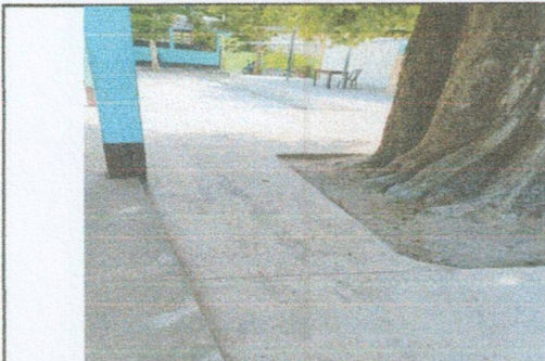
Foto 9: SUSTITUCION DE PLANCHAS DE CONCRETO DE PATIO
