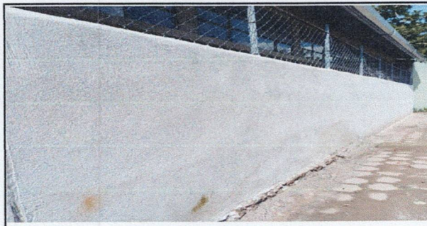
Foto 6: REPELLO MURO PERIMETRAL
