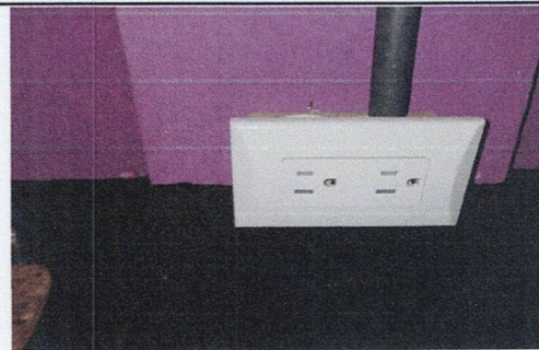
Foto 4: SUSTITUCION DE UNIDAD DE FUERZA (CAJA, TOMACORRIENTE, ALAMBRADO Y DUCTO)
