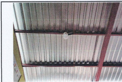
Foto 3: SUSTITUCION DE LUMINARIA (PLAFONERA, FOCO, ALAMBRADO Y DUCTO)
