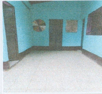
Foto 2: INSTALACION DE PISO CERÁMICO EN AULAS
