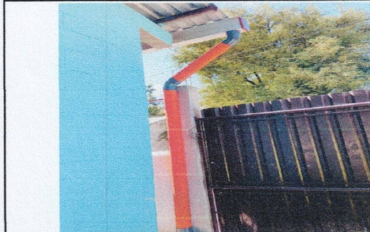
Foto 8: INSTALACIÓN DE TUBERIA PVC EN LÍNEA PRINCIPAL DE AGUA PLUVIAL
