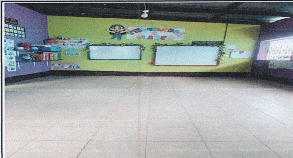
Foto1: INSTALACION DE PISO CERÁMICO EN AULAS
