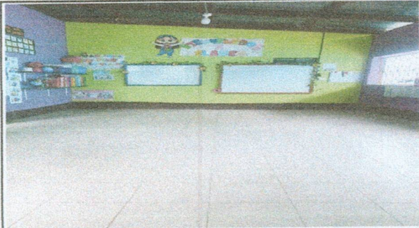
Foto1: INSTALACION DE PISO CERÁMICO EN AULAS
