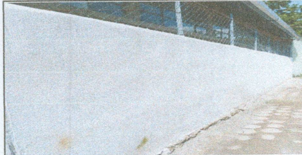
Foto 6: REPELLO MURO PERIMETRAL
