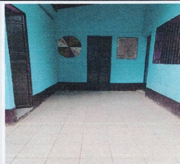
Foto 2: INSTALACION DE PISO CERÁMICO EN AULAS
