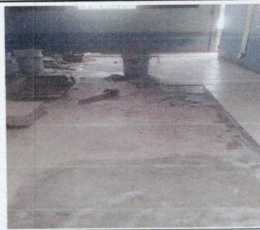
Foto 2: INSTALACION DE PISO CERÁMICO EN AULAS
