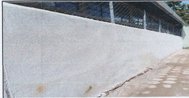
Foto 6: REPELLO MURO PERIMETRAL
