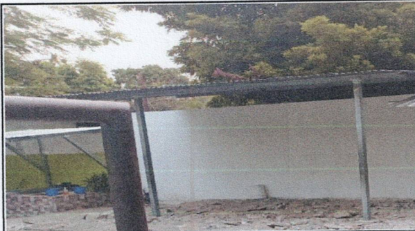
Foto 7: CERNIDO EN MURO PERIMETRAL
