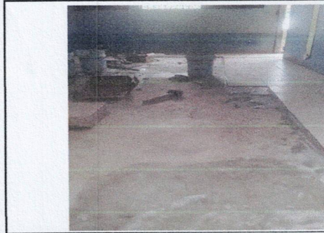
Foto 2: INSTALACION DE PISO CERÁMICO EN AULAS
