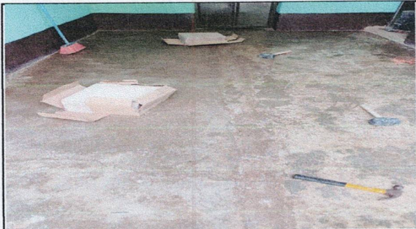
Foto1: INSTALACION DE PISO CERÁMICO EN AULAS
