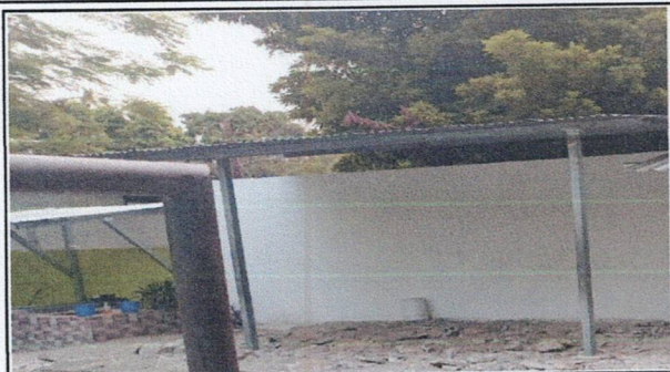
Foto 7: CERNIDO EN MURO PERIMETRAL
