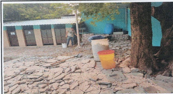
Foto 9: SUSTITUCION DE PLANCHAS DE CONCRETO DE PATIO
