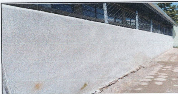
Foto 6: REPELLO MURO PERIMETRAL
