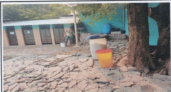
Foto 9: SUSTITUCION DE PLANCHAS DE CONCRETO DE PATIO
