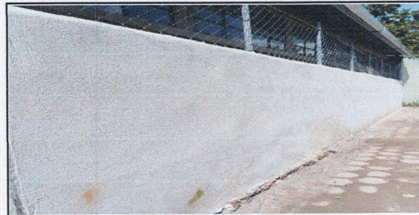
Foto 6: REPELLO MURO PERIMETRAL
