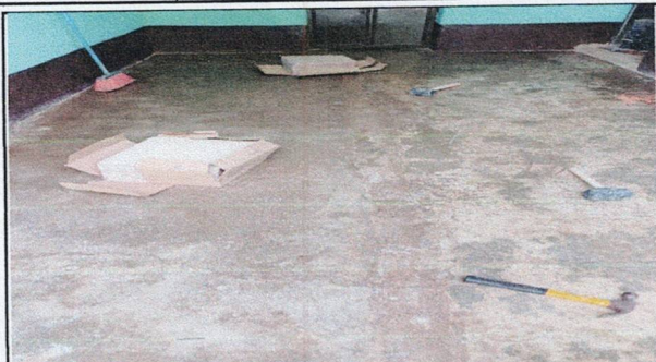
Foto 1: INSTALACION DE PISO CERÁMICO EN AULAS
