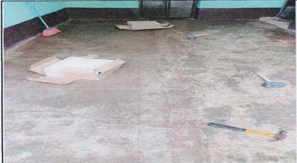
Foto 1: INSTALACION DE PISO CERÁMICO EN AULAS
