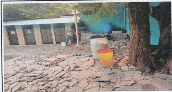
Foto 9: SUSTITUCION DE PLANCHAS DE CONCRETO DE PATIO
