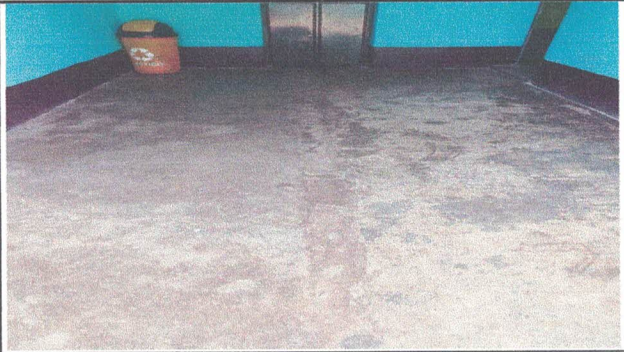
Foto1: AULA: Instalacion de piso cerámico
