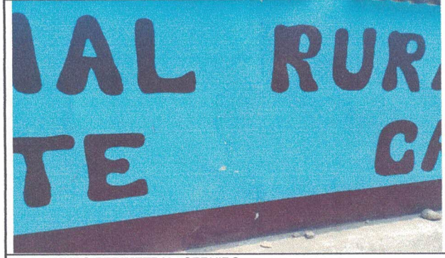
Foto 6: MURO PERIMETRAL: CERNIDO
