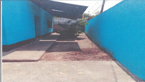
Foto 8: LOSA DE PATIO: Sustitución de planchas de concreto de patio
