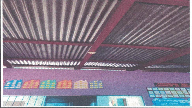
Foto 2: AULA: Sustitución de luminaria
