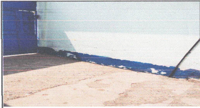
Foto 1: Pintura de muros exteriores
