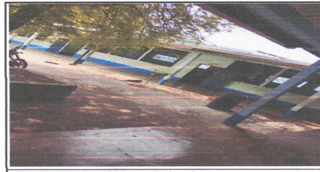
Foto 6: Mantenimiento de puertas, lijado y pintura
