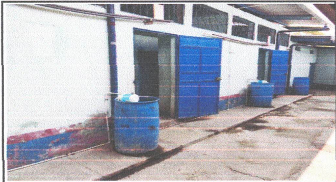
Foto 2: Mantenimiento de puertas, lijado y pintura
