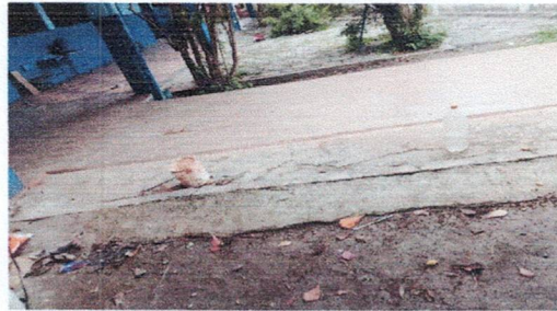
Foto 2: Reparación de piso ceramico de corredor 4
