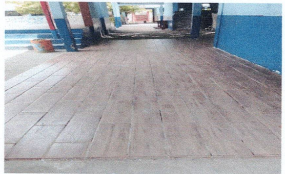
Foto 4: Reparación de piso cerámico de corredor 2
