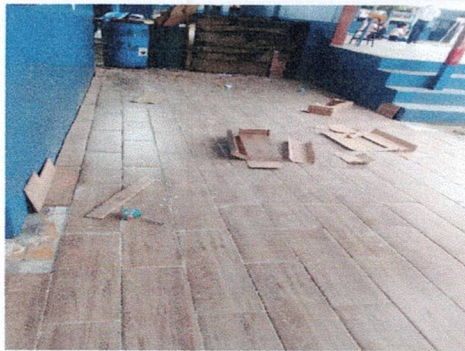
Foto 5: Reparación de piso ceramico de corredor 3
