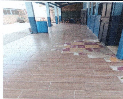
Foto 6: Reparación de piso ceramico de corredor 3
