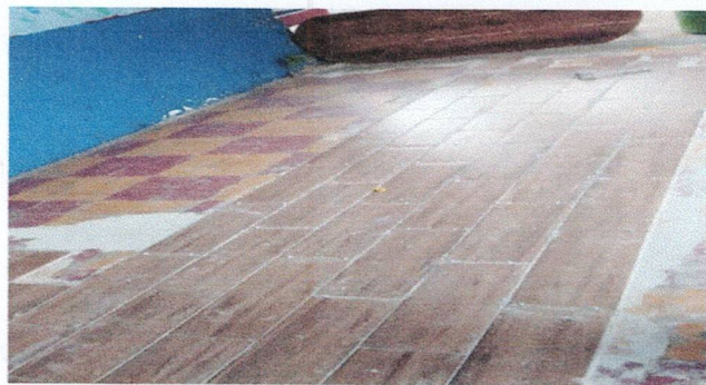
Foto 3: Reparación de piso cerámico de corredor 2
