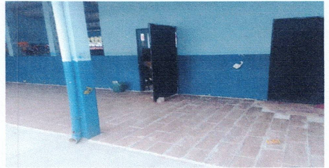
Foto 2: Reparación de piso ceramico de corredor 1
