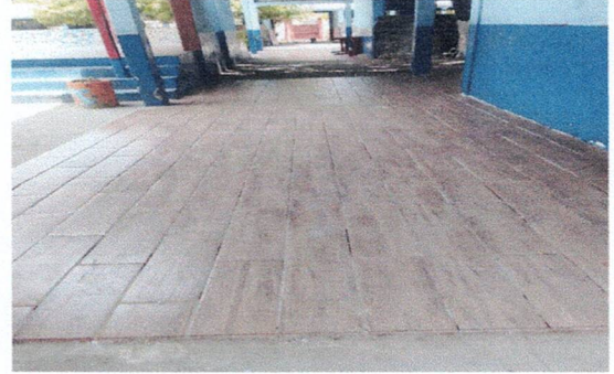
Foto 4: Reparación de piso ceramico de corredor 2
