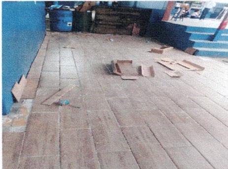
Foto 5: Reparación de piso ceramico de corredor 3
