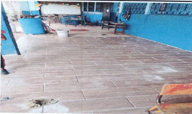
Foto 3: Reparación de piso cerámico de corredor 4
