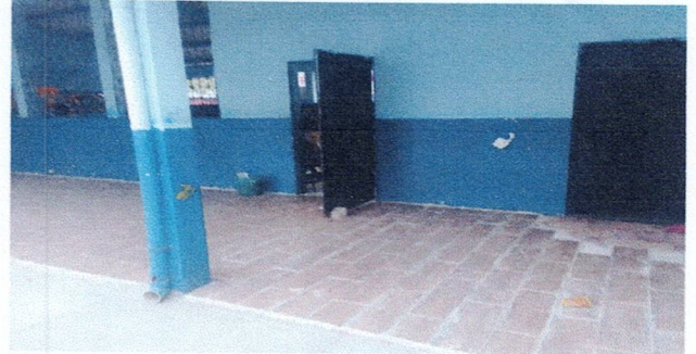
Foto 2: Reparación de piso cerámico de corredor 1
