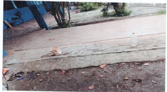
Foto 2: Reparación de piso cerámico de corredor 4
