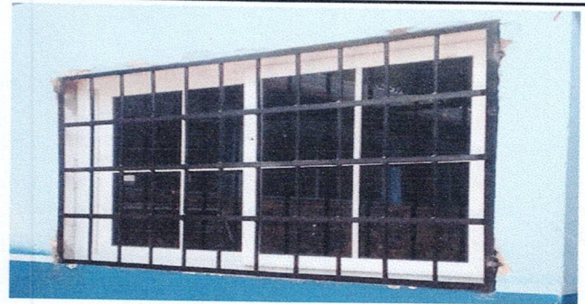
Foto 4: Sustición de balcón de cocina
