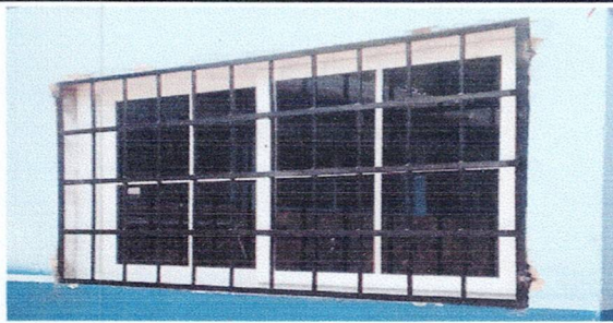
Foto 4: Sustición de balcón de cocina
