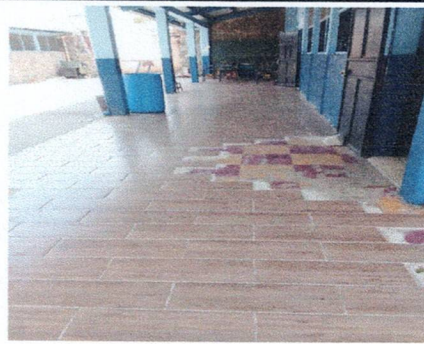
Foto 6: Reparación de piso cerámico de corredor 3
