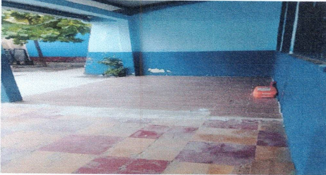
Foto1: Reparación de piso cerámico de corredor 1
