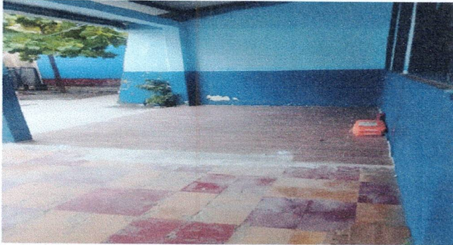
Foto1: Reparación de piso ceramico de corredor 1
