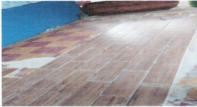
Foto 3: Reparación de piso ceramico de corredor 2
