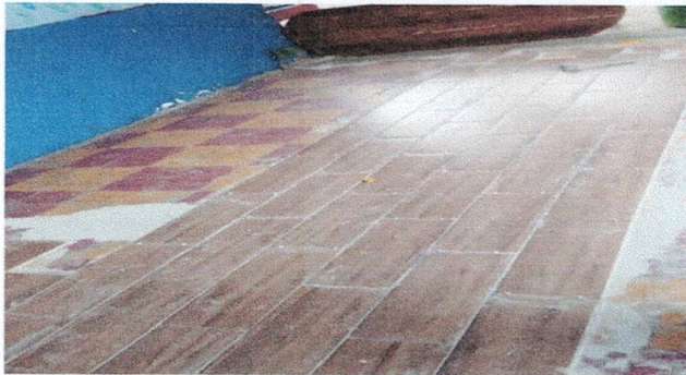
Foto 3: Reparación de piso ceramico de corredor 2
