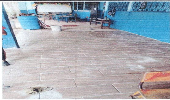
Foto 3: Reparación de piso ceramico de corredor 4
