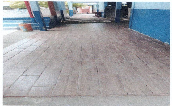
Foto 4: Reparación de piso ceramico de corredor 2
