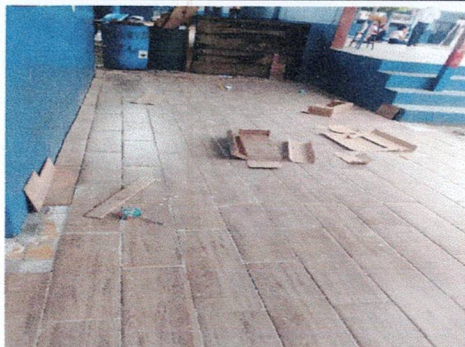
Foto 5: Reparación de piso cerámico de corredor 3
