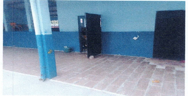
Foto 2: Reparación de piso ceramico de corredor 1
