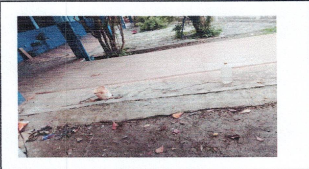
Foto 2: Reparación de piso ceramico de corredor 4
