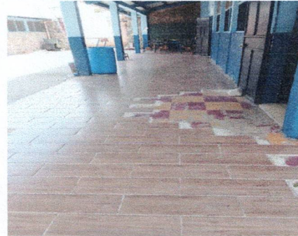
Foto 6: Reparación de piso ceramico de corredor 3
