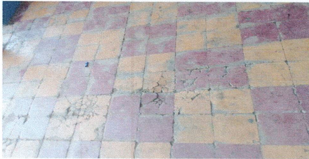
Foto 3: Reparación de piso ceramico de corredor 2
