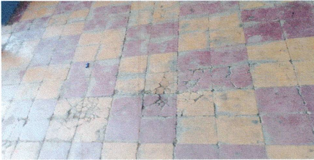
Foto 3: Reparación de piso ceramico de corredor 2
