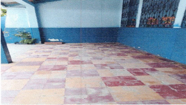
Foto1: Reparación de piso ceramico de corredor 1
