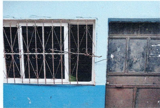
Foto 6: Sustitución de balcón de cocina
