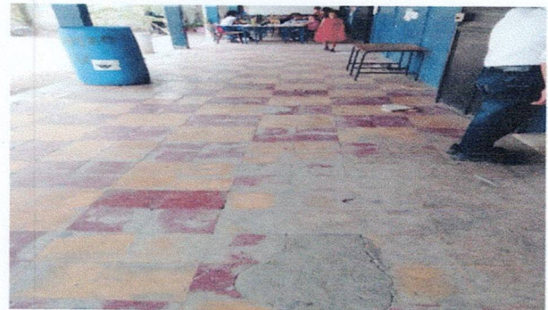
Foto 4: Reparación de piso ceramico de corredor 3
