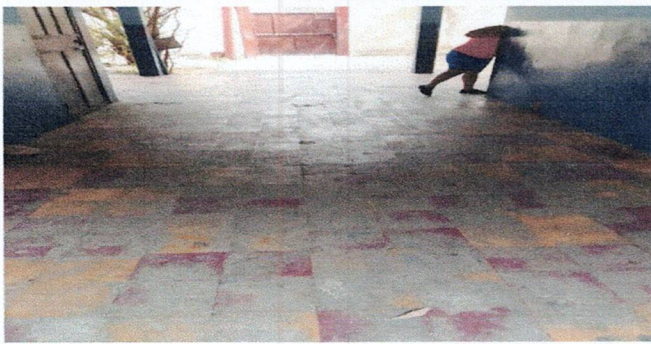
Foto 5: Reparación de piso ceramico de corredor 4
