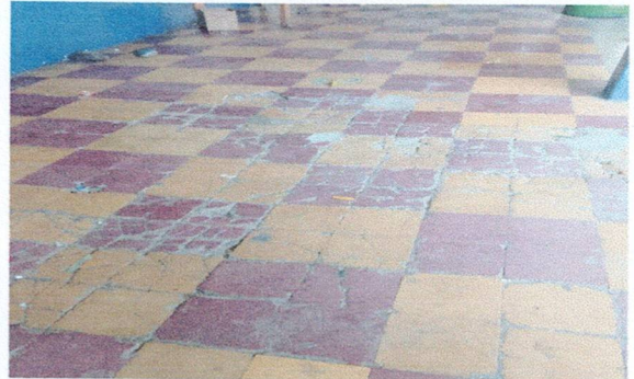
Foto 2: Reparación de piso ceramico de corredor 1
