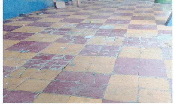
Foto 2: Reparación de piso ceramico de corredor 1
