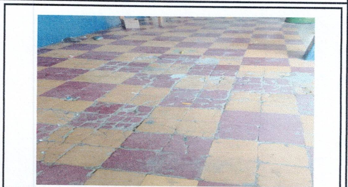
Foto 2: Reparación de piso ceramico de corredor 1
