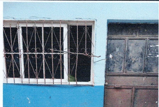
Foto 6: Sustitución de balcón de cocina
