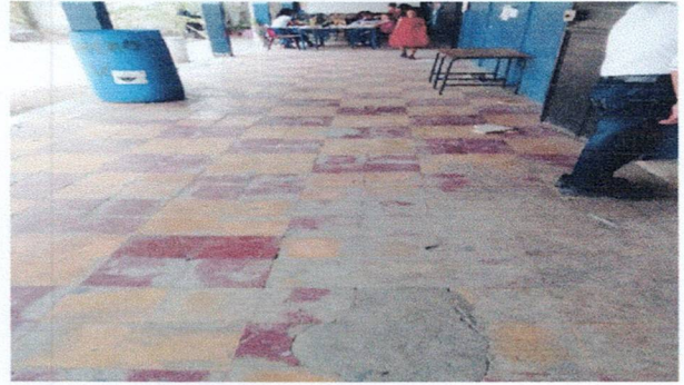
Foto 4: Reparación de piso ceramico de corredor 3
