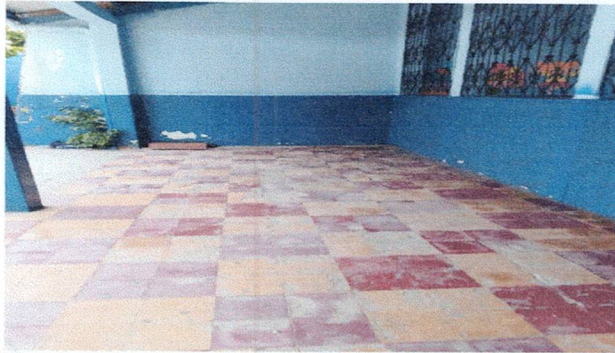
Foto 1: Reparación de piso ceramico de corredor 1
