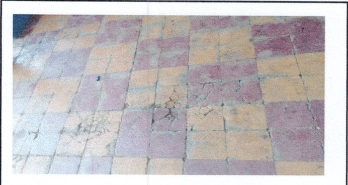
Foto 3: Reparación de piso ceramico de corredor 2
