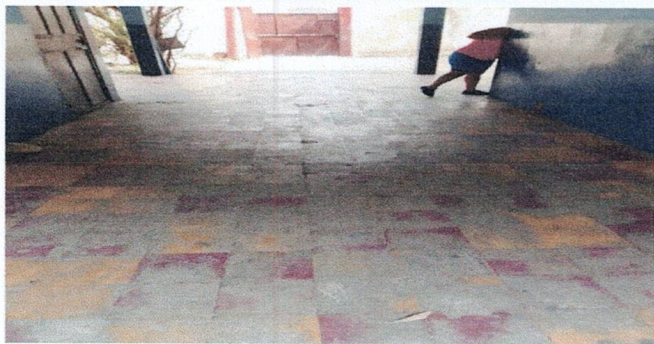
Foto 5: Reparación de piso ceramico de corredor 4
