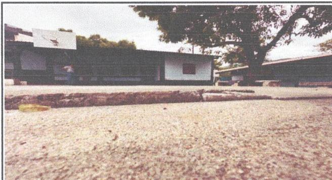
Foto 9: PISO DE CEMENTO EN CANCHA QUE NECESITA REPOSICION, (DEMOLICION DE 15 CM DE PLANCHAS EXISTENTES) ✓
