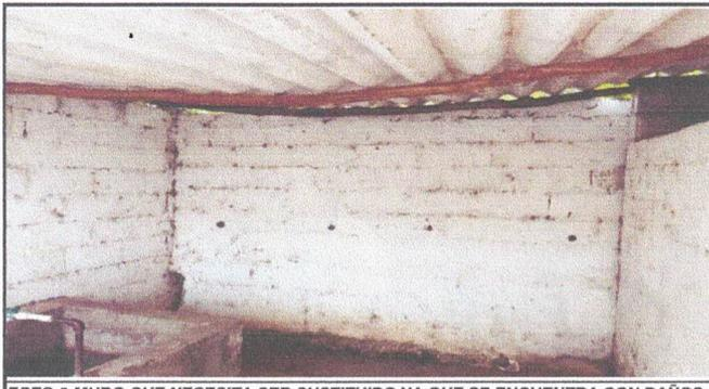
FOTO 5: MURO QUE NECESITA SER SUSTITUIDO YA QUE SE ENCUENTRA CON DAÑOS Y ESTA PROPENSO A DERRUMBARSE.. ESTE MURO COMO SE VE MUESTRA YA UN VENCIMIENTO LO QUE PROVOCA UN DESNIVEL VERTIVAL.
