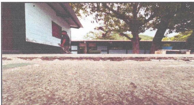
Foto 11: PISO DE CEMENTO EN CANCHA QUE NECESITA REPOSICION, (DEMOLICION DE 15 CM DE PLANCHAS EXISTENTES) ✓
