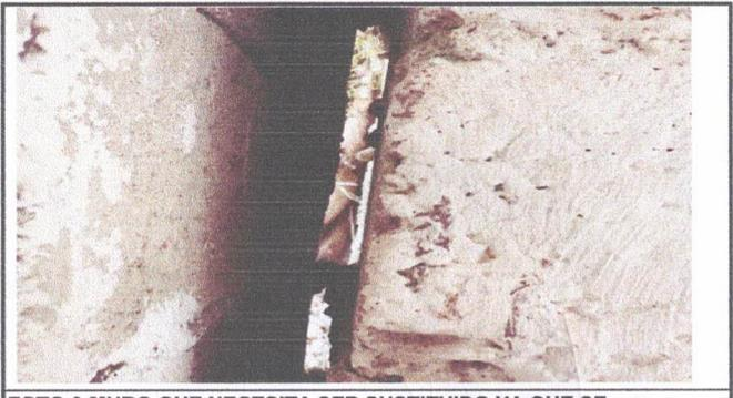
FOTO 6: MURO QUE NECESITA SER SUSTITUIDO YA QUE SE ENCUENTRA CON DAÑOS Y ESTA PROPENSO A DERRUMBARSE..
