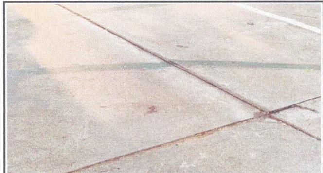
Foto 10: PISO DE CEMENTO EN CANCHA QUE NECESITA REPOSICION, (DEMOLICION DE 15 CM DE PLANCHAS EXISTENTES) ✓
