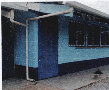
Foto 3: Pintura en Muros Exteriores
