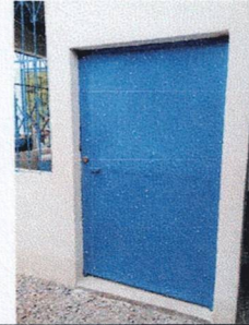
Foto 6: Instalación de puerta en Cocina
