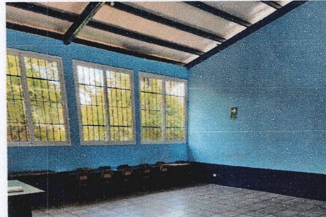
Foto 2: Pintura en muros interiores
