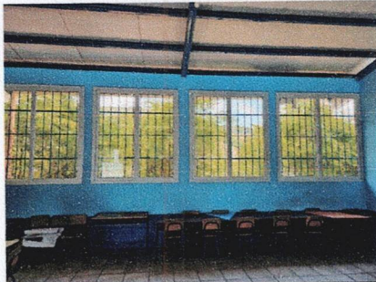
Foto1: Instalación de Ventanas PVC
