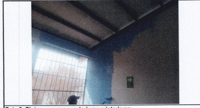
Foto 6: Pintura en muros exteriores e interiores
