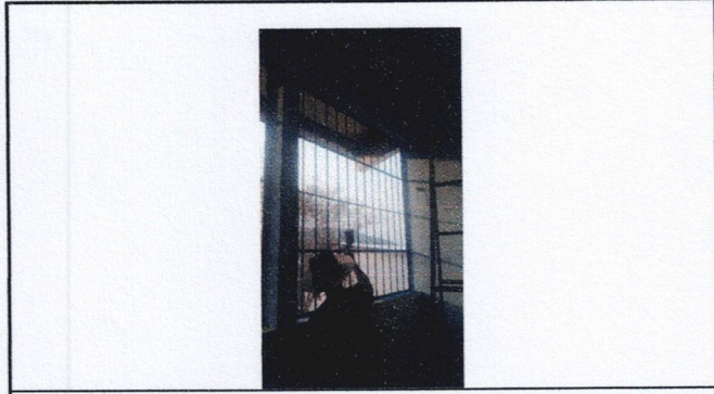
Foto 4: Mantenimiento a estructura de metal de ventanas
