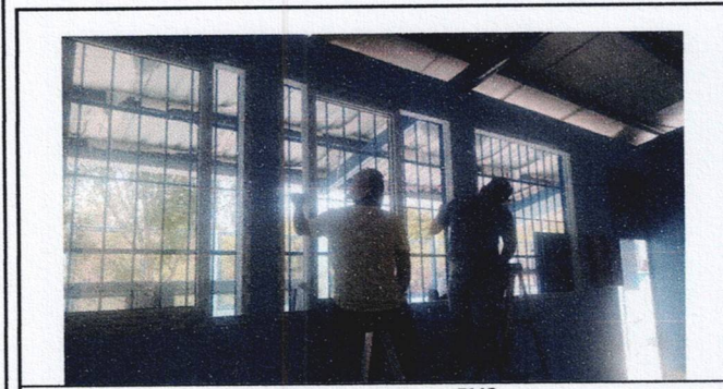
Foto 5: Sustitución e instalación de ventanas PVC
