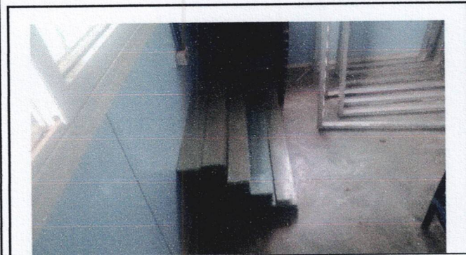
Foto 3: Retiro de marcos y vidrio de ventanas
