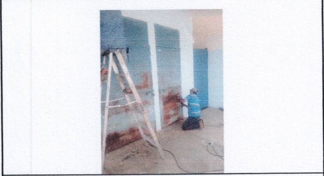
Foto 2: Mantenimiento de Puertas en Aulas y dirección
