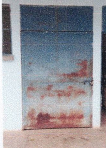
Foto 5: Mantenimiento de puertas de aulas
