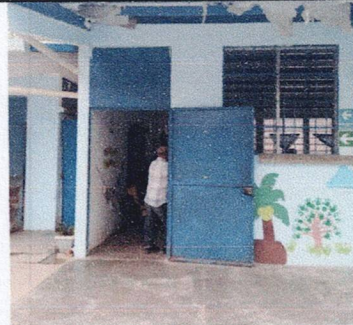
Foto 2: Sustitución de Piso en Aula Pura y Corredo de Parvulos, Sustitución de ventanas milfinish por ventanas de PVC. Y Aplicación de Pintura Latex para interior y exterior en AULA PURA y hasta donde cubra la cantidad indicada.
