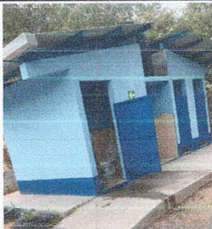
Foto 3: Mantenimiento de Puertas deterioradas.
