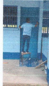
Foto 2: Proceso del mantenimiento de Puerta de aula.
