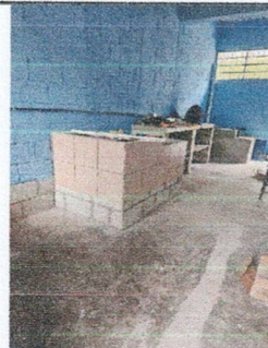
Foto 6: Área preparada para instalación de Piso de la cocina
