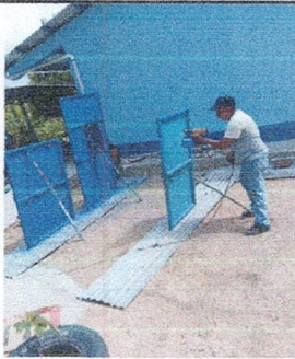
Foto 3: Proceso del mantenimiento de Puertas deterioradas.
