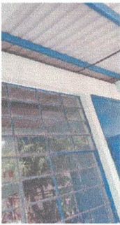
Foto 3: Falta de entavicar muro en la cocina.
