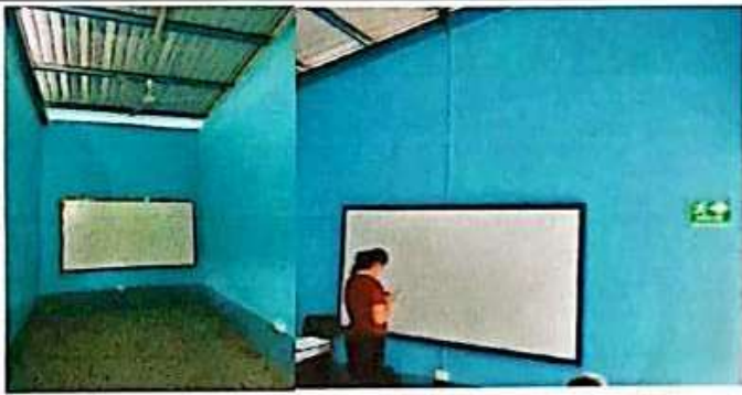
Foto 9: APLICACIÓN DE PINTURA INTERIOR
