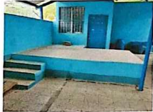
Foto 8: CONSTRUCCION DE TARIMA.
