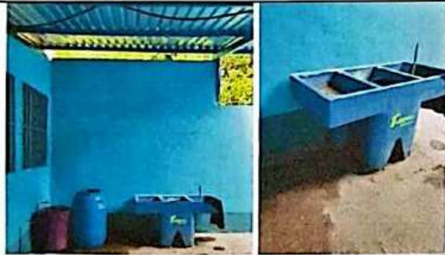
Foto 3: REUBICACION DE PILA EXISTENTE Y LEVANTADO DE MURO.
