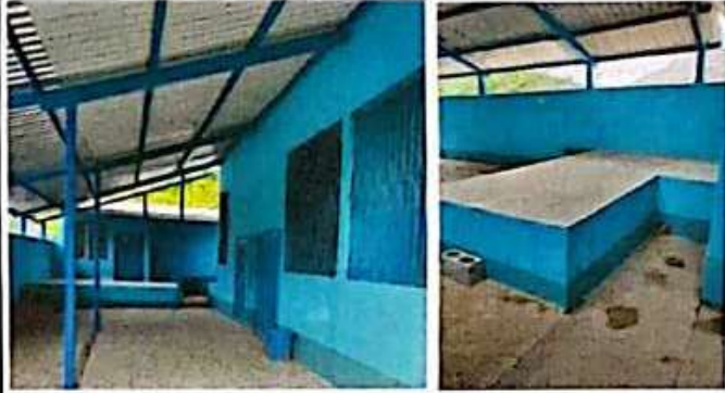
Foto 7: CONSTRUCCION DE TARIMA.
