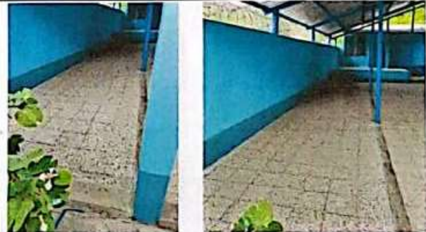
Foto 6: NIVELACION Y COLOCACION DE PISO DE GRANITO.
