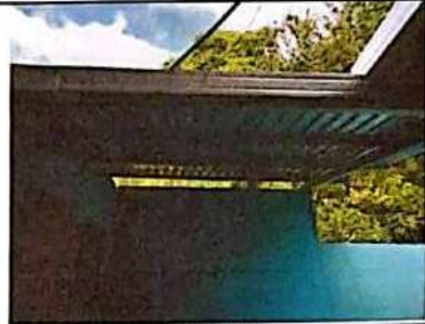
Foto 2: INSTALACION DE CANAL DE METAL.
