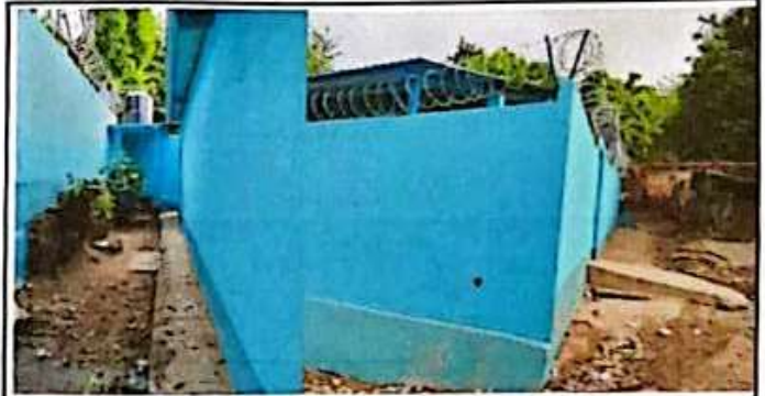
Foto 10: APLICACIÓN DE PINTURA EXTERIOR
