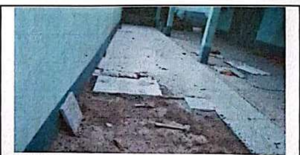
Foto 6: NIVELACION Y COLOCACION DE PISO DE GRANITO.
