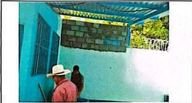
Foto 9: LEVANTADO DE MURO EN AREA DE PILA
