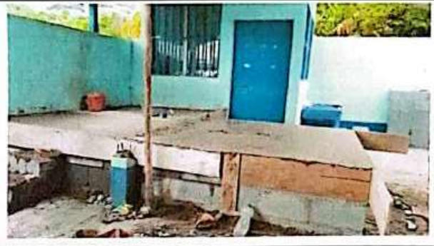
Foto 8: CONSTRUCCION DE TARIMA.
