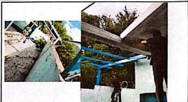
Foto 2: INSTALACION DE TECHO Y CANAL DE METAL.
