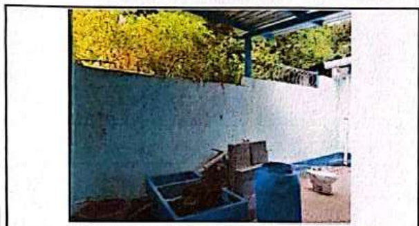
Foto 3: REUBICACION DE PILA EXISTENTE Y LEVANTADO DE MURO.
