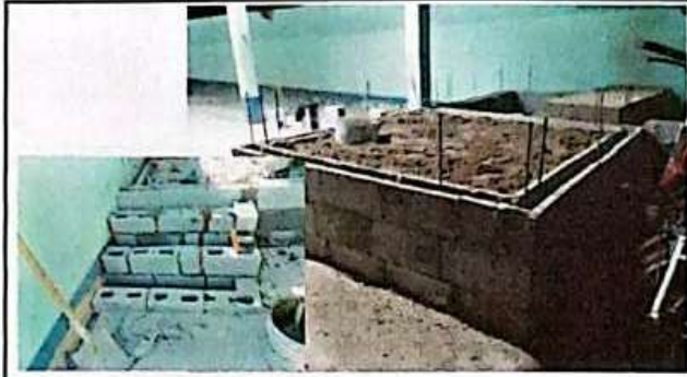
Foto 7: CONSTRUCCION DE TARIMA.
