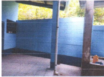
Foto 7: . Pintura en muros exteriores e interiores
