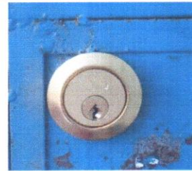
Foto 4: Sustitución de chapas en puerta
