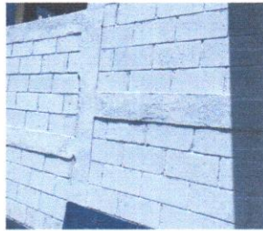
Foto 3: Sellado en grietas y fisuras en muro
