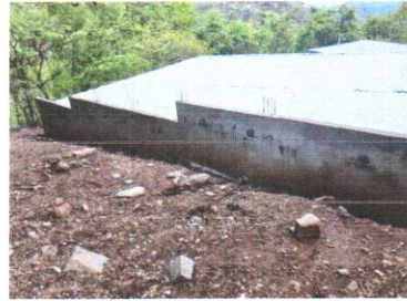
Foto 8: Sustitución muro de contención
