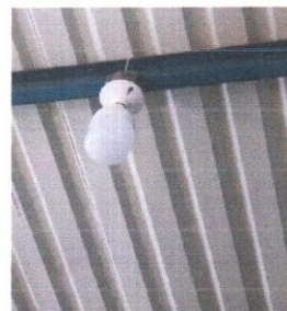
Foto 6: Sustitución de plafoneras y bombillas
